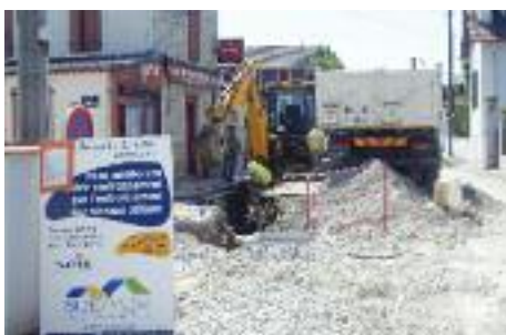
Travaux d'enfouissement électrique à Gan.
